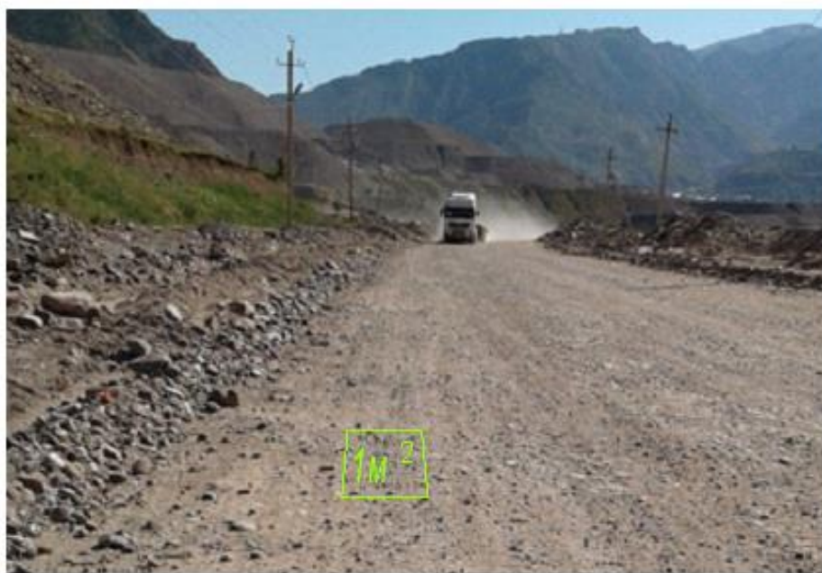
Рис. 1. Фрагмент горной карьерной автодороги
