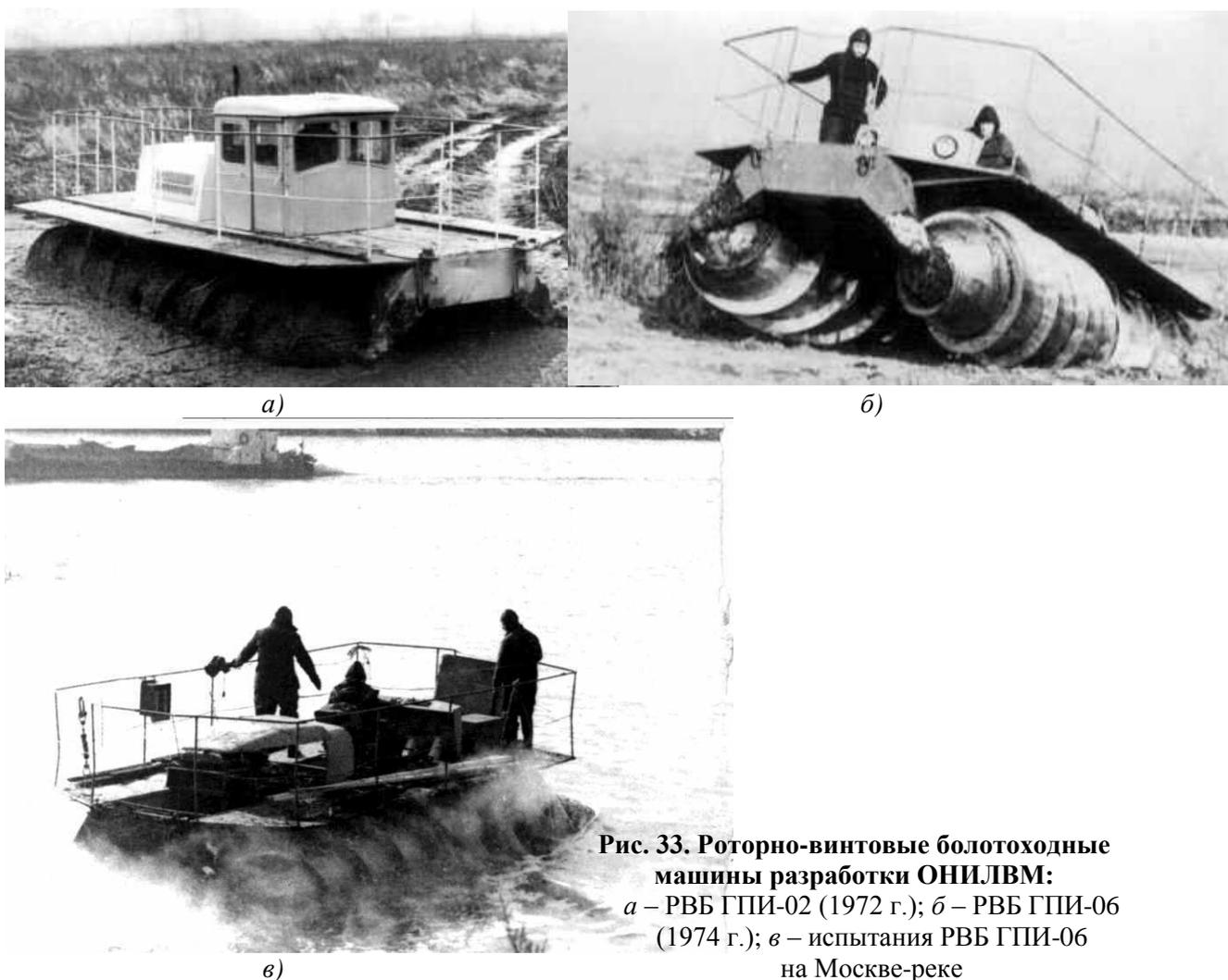
**Рис. 33. Роторно-винтовые болотоходные машины разработки ОНИЛВМ:**
